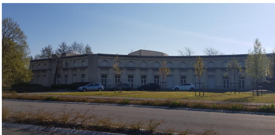
Figure A.5.2-1: Bâtiment Robert Hazebrouck à Béthune accueillant le site du département Artois de l'EILCO
